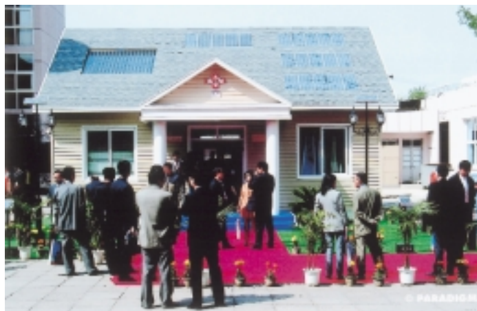
Demohaus mit Systemlösung von Linuo Paradigma Co. Ltd
