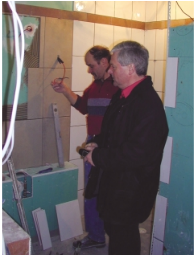
Karl-Heinz Arndt (r.) mit seinem Fliesenleger Hans-Joachim Fanselow vor Ort. Bei Großprojekten sind oft 30 seiner insgesamt 35 Mitarbeiter auf der Baustelle
