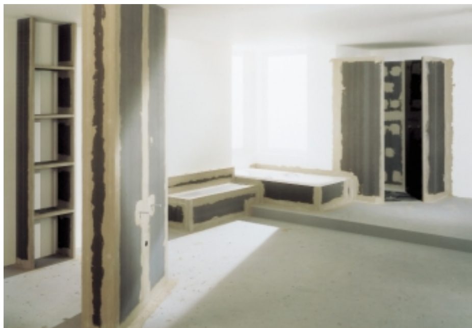
Bild 2 Praxisbeispiel: Die Bauplatten sind armiert bzw. abgedichtet und fertig zum Verfliesen . . .
