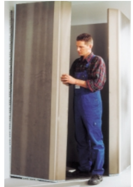
Bild 4 Die Duschtrennwand wird mittels U-Profilen an der Wand und auf dem Boden befestigt
