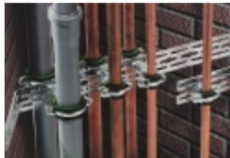
montiert werden. Das spezielle Lochbild der Schiene paßt für alle gängigen Wandanschlußarmaturen und Sanitär-Stichmaße. Bei der Schachtmontage läßt sich die Schiene auch an nicht rechtwinkligen Schachtwänden fixieren. Die Montage der Rohrschellen erfolgt dann mittels passenden Stabo-Fix-Schrauben oder mittels Gewindestift als Durchsteckmontage.
