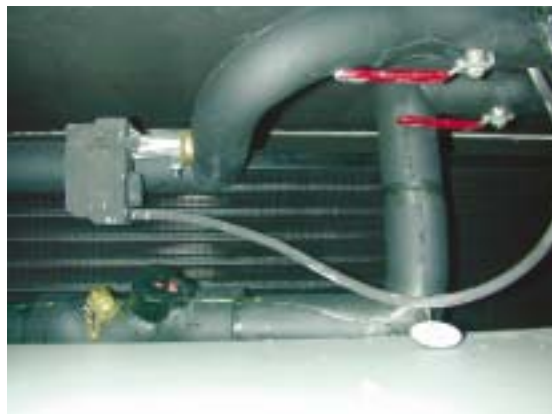
Anschlußdetail Schwerkraftkühler in der Schrankwand
