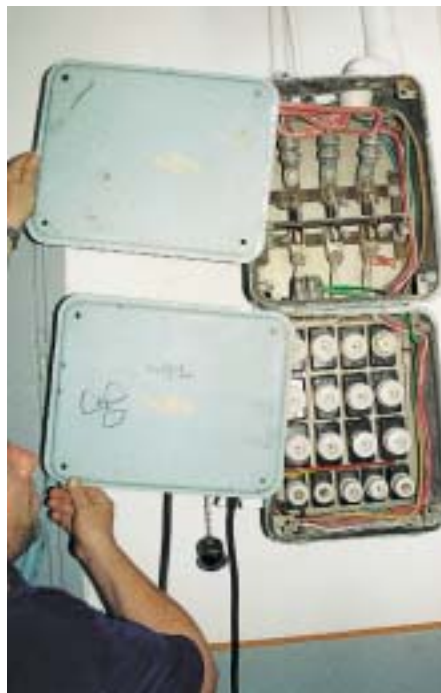
Vor Ort gab es Arbeit satt: Die Elektriker nahmen die Installation unter die Lupe . . .
