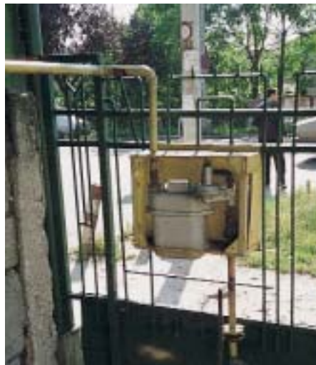
Auch die Gasinstallation war gewöhnungsbedürftig: Ein gut belüfteter Zählerschrank, vorne zu, dafür hinten auf
