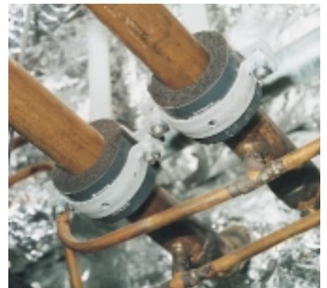
**Bereits bei der Rohraufhängung wurde mittels Armafix NH Rohrträger auf eine wirksame thermische Entkopplung des Rohres geachtet**
