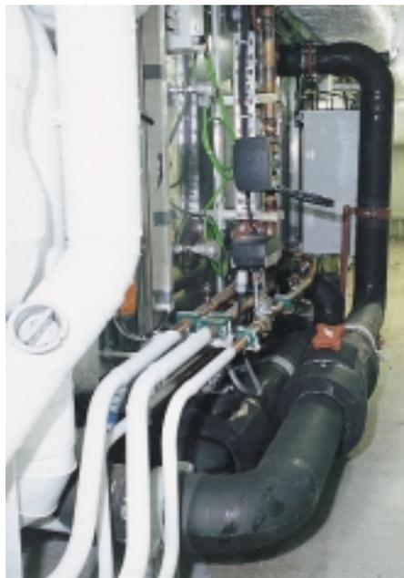
**Mit den halogenfreien elastomeren Dämmstoffmatten werden die Anlagenteile einer Kühlwasserleitung gedämmt**
