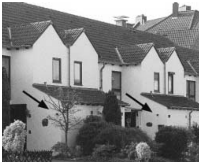
Diese Häuser wurden aus Kostengründen ohne Schornstein gebaut und C_{13} -Geräte eingesetzt: Ein Missbrauch der Ausnahmeregeln
