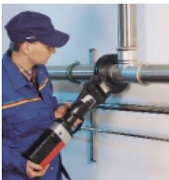
108 mm geschaffen. Von 12 bis 35 mm werden die bekannten Preßbacken verwendet. Ab 42 mm wird mit zusätzlichen Preßschlingen und Adapterbacken gearbeitet.
