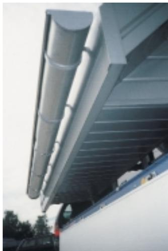
seitige Bekleidung ohne sichtbare Befestigung. Nach Herstellerangaben sollen die Montagezeiten durch den Einsatz der vollständigen Systemlösung reduziert werden können und Wartungsarbeiten nicht erforderlich sein. Eine Fertigung der Flächenprofile erfolgt aus vorbewittertem Rheinzink.
