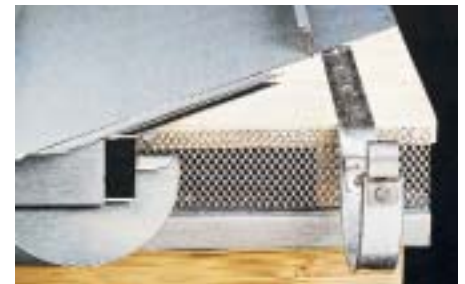
Zuluftschlitz unter der Dachrinne, ausgeführt mit Rautenlochblech „Aero 63“
