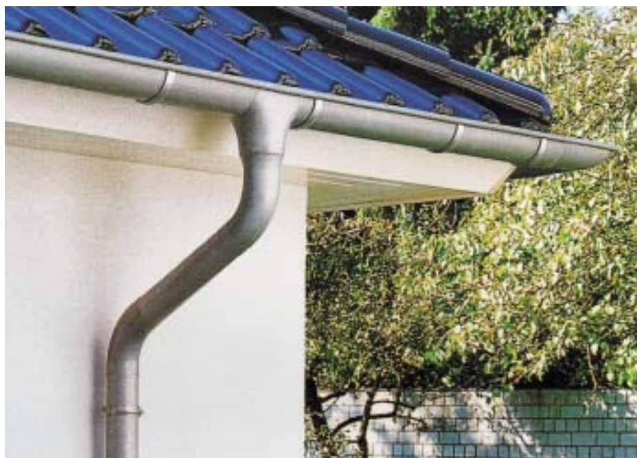
Traufsituation an einem Wohnhaus, ausgeführt mit dem variablen Teleskopanschluß-Set für Dachüberstände von 350 bis 1120 mm
