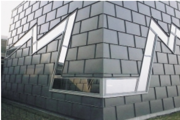
Bild 3 Das Fensterband im Zick-Zack-Verlauf lockert die Raster der Fassadenbekleidung auf
