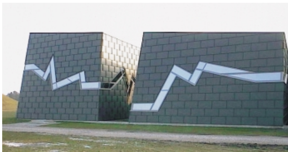
Bild 1 Die beiden kubusförmigen Ausstellungsräume mit ihren abgeschragten Gebäudekanten haben eine Fassadenbekleidung in Klempnertechnik
