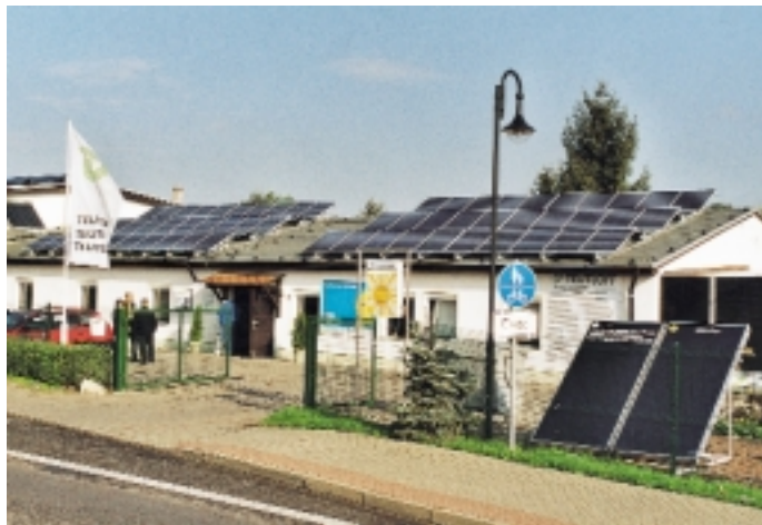
Blickfang ist die solare Dachlandschaft des Ökologischen Zentrums in Barby
