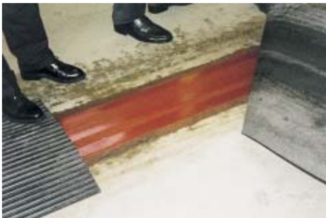
. . . gleitet innerhalb von sechs Stunden auf zahlreichen dieser Stahlschienen in die Arena
