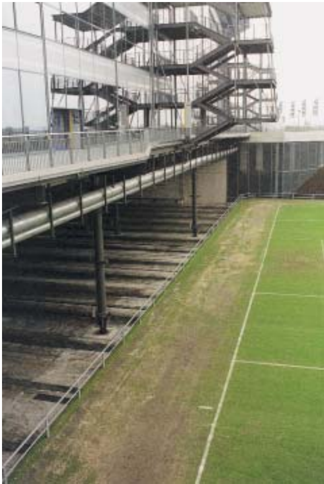
Die 11 000 Tonnen schwere Betonwanne mit dem Spielfeld . . .
