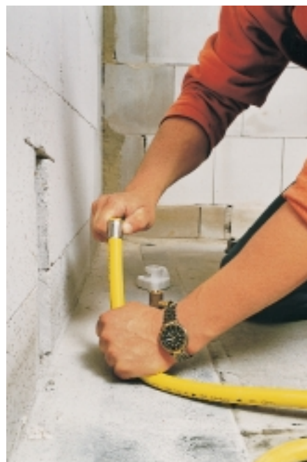
... die Preßverbinderhülse wird aufgesteckt,
