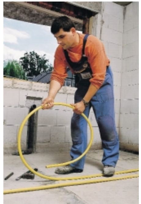
Die Verarbeitung „von der Rolle“ minimiert Rohrverbindungen und verkürzt die Montagezeit
