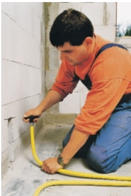
Nach dem Ablängen wird das Rohrende kalibriert und entgratet,
