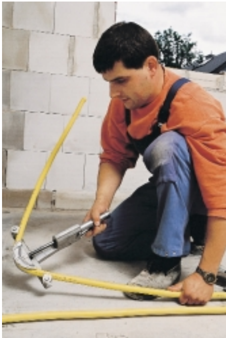
Richtungsänderungen können von Hand mit einem Biegeradius von 5 \times da , oder mit Werkzeug mit Radius von 3,5 \times da hergestellt werden
