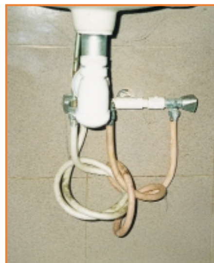
Manchmal fehlen die Worte und der Mensch wundert sich nur noch. Anscheinend hat auch diese Spaghetti-Installation jahrzehntelang ihren Dienst getan. Das Foto schickte uns freundlicherweise Anja Rittweger von der Ress GmbH im thüringischen Römheld. Aufgenommen wurde es in einem Vier-Sterne-Hotel auf Sri Lanka
