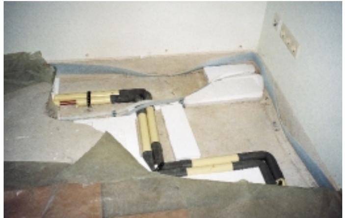
**Aufwendige Verlegemaßnahmen bei den PUR-ummantelten Wicu\_extra-Heizungsrohren, um Knackgeräusche durch Längenausdehnung zu vermeiden**
