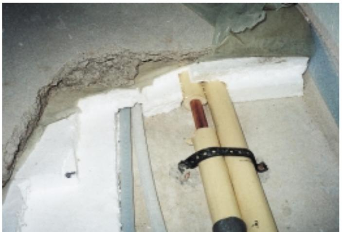
**Knackgeräusche aufgrund falsch ausgeführter Estrichdämmung. Grund: Bei Längenausdehnung des Rohres entsteht Reibung zwischen PUR-Dämmung und PS-Dämmstoffplatte**
