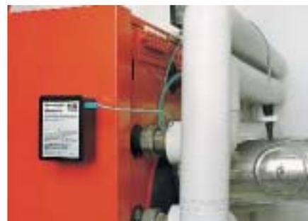
auf den Jahresnutzungsgrad der Feuerstätte geschlossen werden. Außerdem werden die genauen Betriebszeiten ermittelt. Das Gerät speichert die gemessenen Daten systematisch (Datenloggerfunktion). Eine Infrarotschnittstelle dient zur Datenübertragung zum PC. Eingebaute Batterien ermöglichen den netzunabhängigen Betrieb über etwa drei Jahre.
