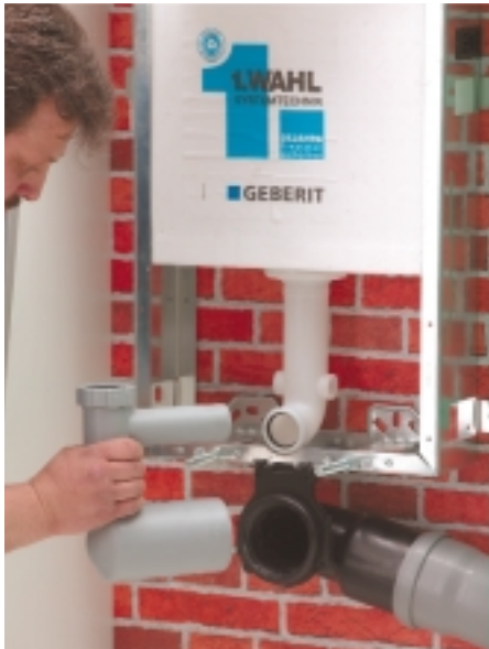
Die beiden Rohrenden des „Prüffix“ werden mit Spülkastenablaufrohr und Abwasserrohr verbunden
