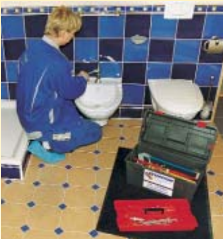
Kleinreparaturen, wie die Reparatur oder das Auswechseln von Armaturen, sind typische LIKA-Aufträge
