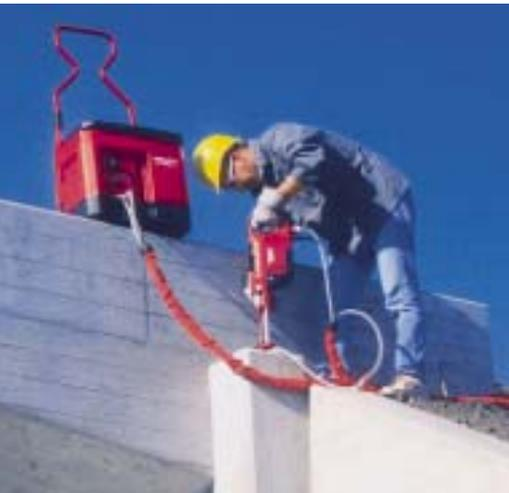
**Das neue Kernbohrgerät DD EC-1 von Hilti**
