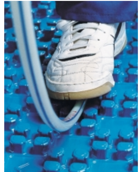
Spitzenreiter bei den Befestigungssystemen mit einem Marktanteil von 52 %: die Noppenplatte
