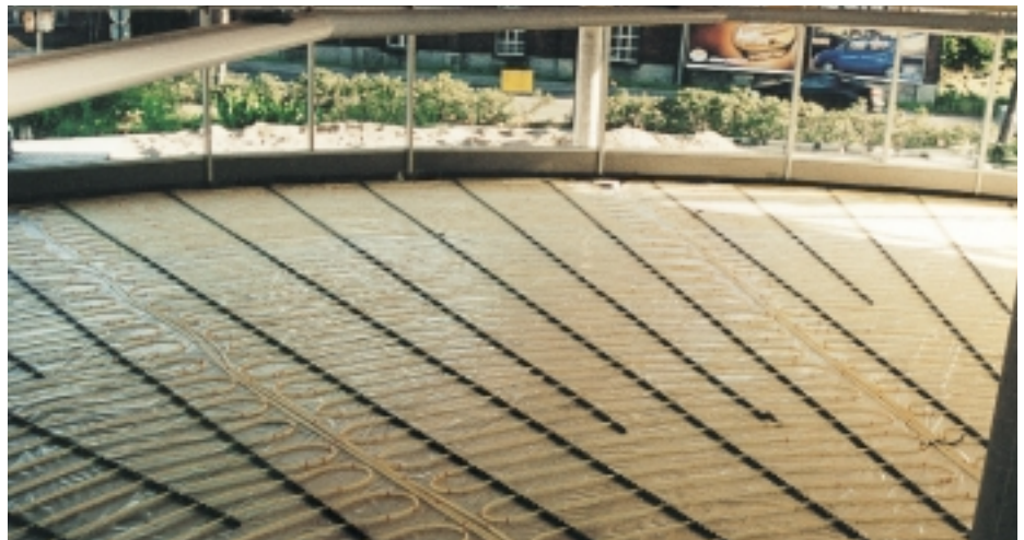
Schienensysteme werden als Rohrbefestigung in der Flächentemperierung selten genutzt. Ihr Marktanteil in Deutschland liegt bei etwa 3 %
