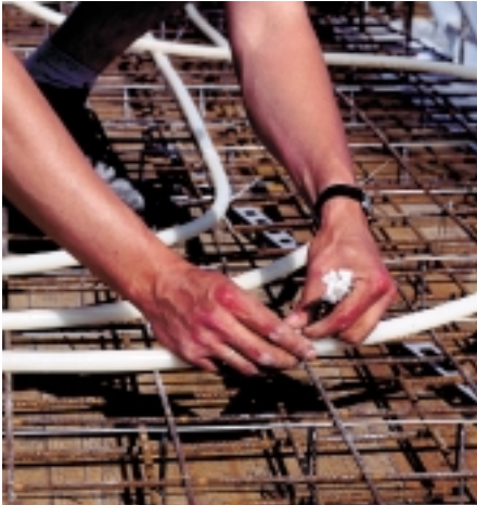
Aufgrund ihrer hohen Belastbarkeit werden im Industriebau häufig Stahlmatten verwendet. Die Befestigung der Rohre erfolgt z. B. mit Kabelbindern
