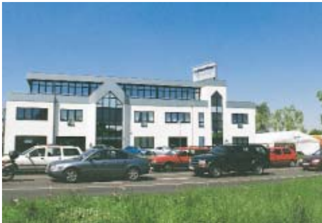
Werbewirksam und verkehrsgünstig an der Bundesstraße von Aachen nach Mönchengladbach gelegen: Der neue Firmensitz der Gebr. Steffen GmbH
