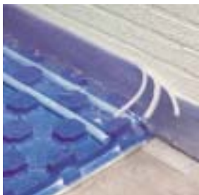
Im Kassenraum und dem Zooshop wurde aufgrund der geringeren Lasten das FBH-System SST Vari-P eingebaut
