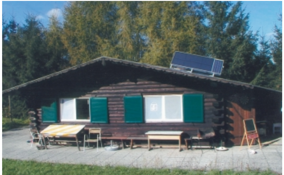
Solarautarke Belüftung und Temperierung einer Ferienhütte bei Graz mit einem 2,5 m 2 großen „Twinsolar“-Luftkollektor
