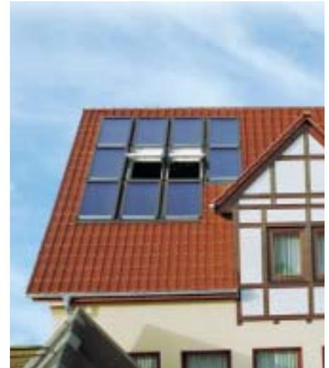
**Kombination von Solarkollektoren des Roto Solarsystems und Wohndachfenstern**
