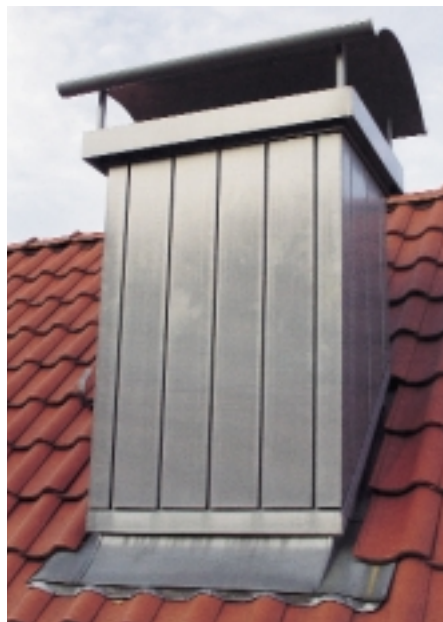
Schornsteinkopfbekleidung, ausgeführt mit schlanken Steckfalzpaneelen aus vorbewittertem Titanzink und Einfassung mit Anformzink am Übergang auf das Dach sowie geschwungener Abdeckung
