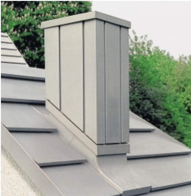
Maßgeschneiderte Schornsteinkopfbekleidungen mit Hilfe von Steckfalzpaneelen erleichtern dem Klempner die Anbringung
