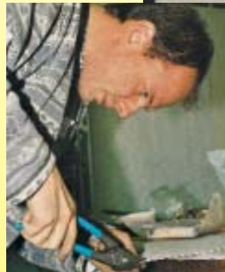
Um einen genauen Zuschnitt zu erhalten, wurde zur Abwicklung auf das Blech geklebt
