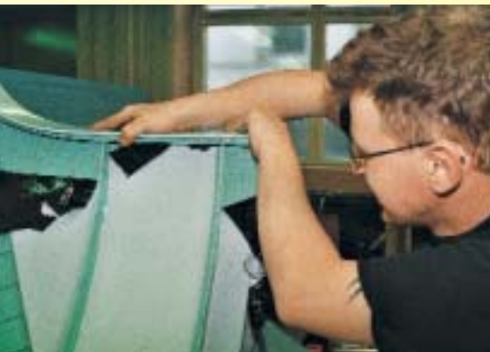
Der First der Gaube wird durch eine Schiebeleiste abgedeckt
