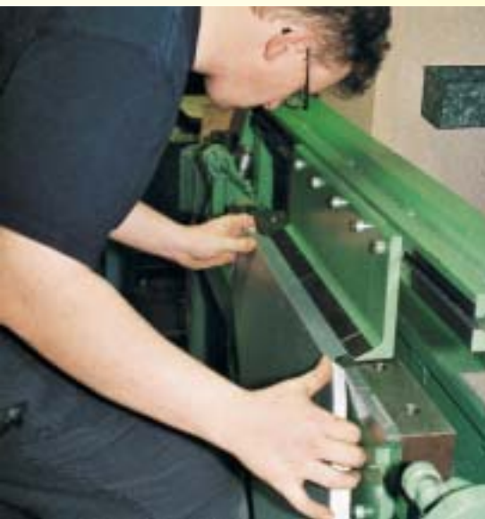
Vorbereiten der Winkelstehfalze für die Wandbekleidung
