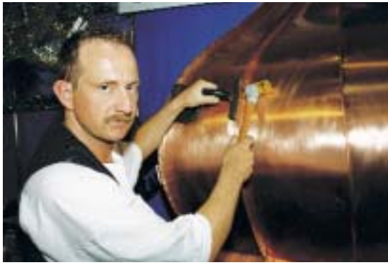
Falzarbeiten am Modell eines kupfernen Zwiebelturms zeigte Arno Fell von der Meisterschule Schweinfurt
