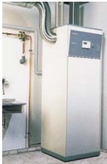
Solarfähiges Integralsystem LWA 203/303..SOL für Lüftung, Heizung und Warmwasserbereitung
