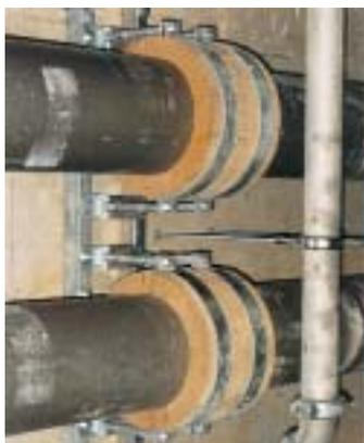
**Energielöcher an Befestigungspunkten entstehen nicht, wenn die Einlagen ausreichende Dämmwirkung haben. Müpro greift hier auf Holzeinlagen zurück**
