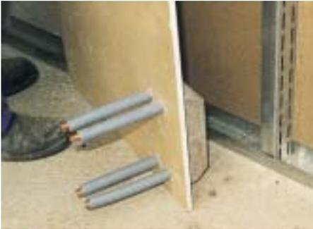
**Der Anschlußblock von Schöko kann mit einer Einbautiefe von weniger als 70 mm in die Ständerbau-Wand eingebaut werden**
