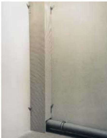
**Mit den vorgefertigten Winkelelementen kann der Installateur seine Rohrleitungen selbst einkasten**
