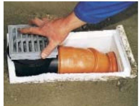
**Erst wenn alle Verschmutzungsgefahr auf der Baustelle vorbei ist, wird der Gully eingebaut**
