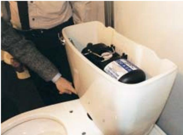
**Im Spülkasten eingebaut befindet sich der Druckbehälter aus Kunststoff**
