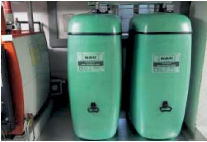
Bis zu zehn der doppelwandigen TwinSafe-GFK-Öltanks lassen sich zusammenkoppeln
