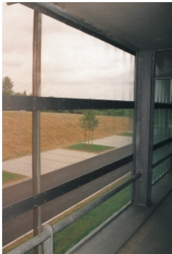
Von außen Sichtschutz, von innen interessante Ausblicke. Die Befestigung der Streckmetalltafeln von innen
