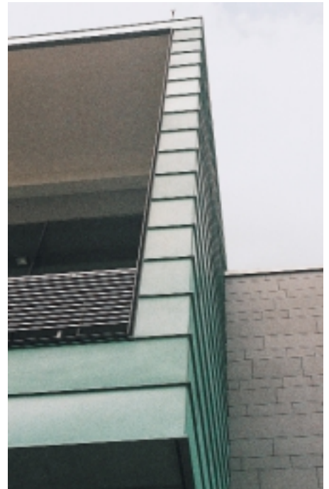
Die Eckausbildung der waagerechten Winkelstehfalze vermittelt den Eindruck einer durchgehend aufgesetzten Wulst
