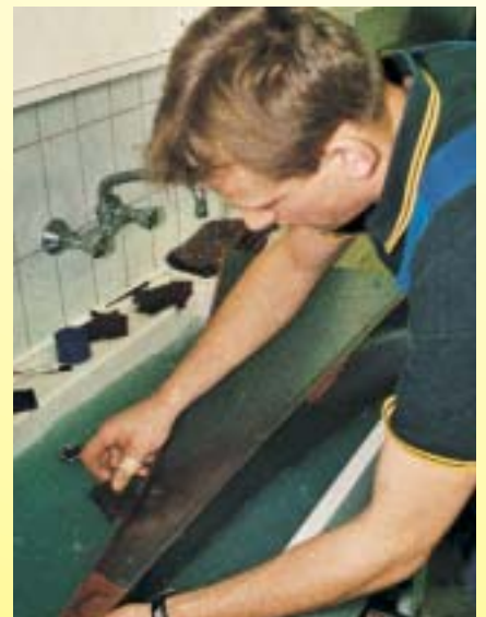
Um zu verhindern, daß Flußmittelreste zu Verfärbungen führen, werden diese mit Seifenlauge neutralisiert
