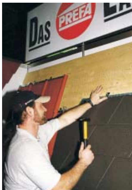
Prefa demonstrierte das Aufbringen schindelförmiger Deckenelemente
