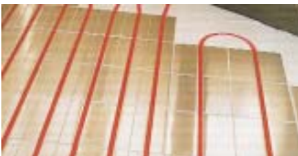
Den Fußbodenheizbereich hat Rehau um ein Trockensystem ergänzt
