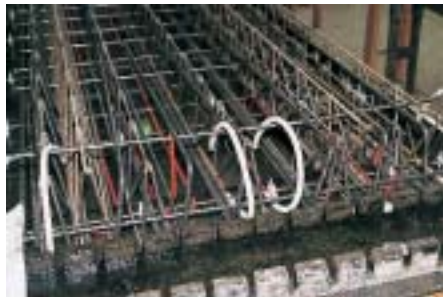
Die Klimarohre des hexacool-Systems liegen unter der Armierung und nur ca. 20 mm unter der Deckenoberfläche
