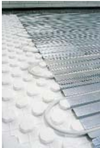
Die neue Noppenplatte von Würth eignet sich auch für trockenverlegte Fußbodenheizungen
