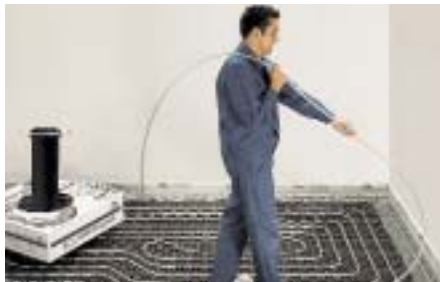
Die Noppensystemplatten des xnet C11-Systems von Kermi ermöglichen auch eine Diagonalverlegung von 45°
