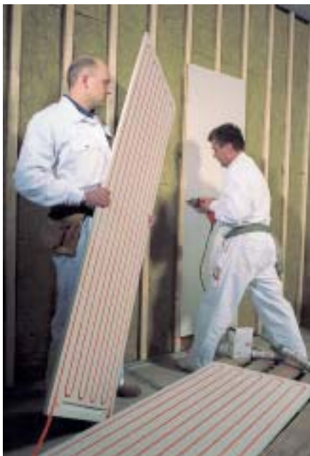
Die Modul-Wandheizung von Variotherm für den Trockenbau besteht aus einzelnen Plattenelementen mit Rohren
