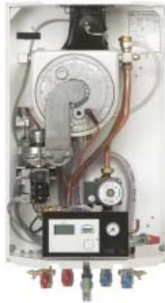
Der Gas-Brennwertkessel ProCon von MAN Heiztechnik bietet einen übersichtlichen Aufbau
