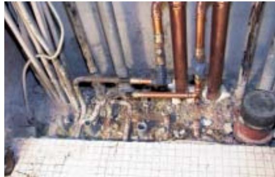
**Im neuen Schacht wurden auch die in Preßtechnik verlegten Vor- und Rückläufe der Heizung geführt und mit der „Tichelmann-Heizung“ verbunden**
