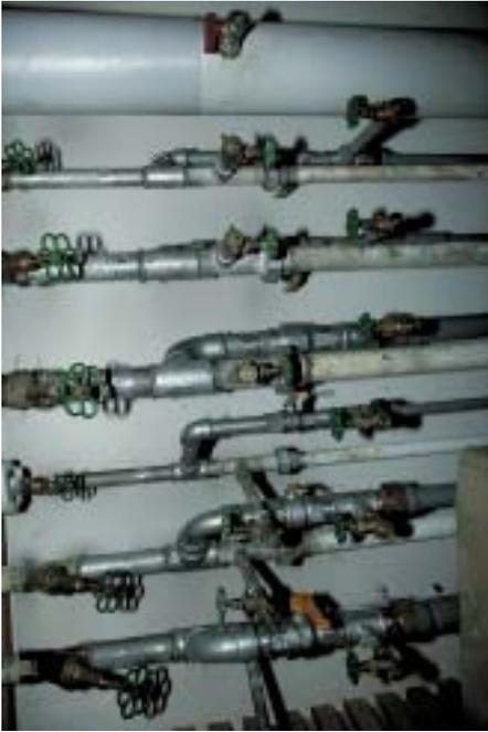
**Verbindungen mit den alten Leitungen im Kellergeschoß sicherten die Wasserversorgung über die neuen Rohrleitungen**
