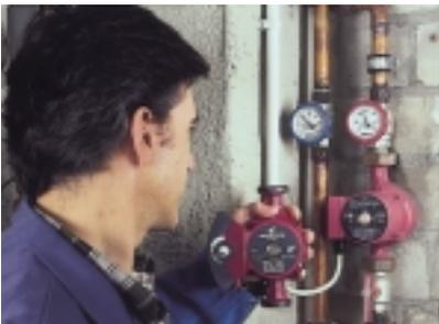
piert. Mit den Einbaulängen von 130 und 180 mm sowie den Anschlußgrößen G 1 1/2 sowie G 2 paßt sie in fast alle Heizungsanlagen. Außerdem sorgt der steckbare Stromanschluß auch bei ungünstigen Einbausituationen für eine einfache Montage. Zum andern verfügt das Alpha-Modell über eine aktivierbare Funktion, welche die Förderleistung bei Nachtabsenkung automatisch reduziert. Die Antiblockierwelle und die elektronische Starthilfe sorgen für das Anlaufen der Pumpe nach längerem Stillstand.
