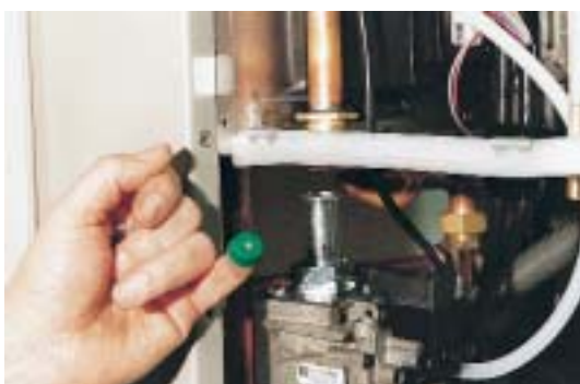
Die grüne Gasdrosselblende entspricht dem Leistungsbereich „öko“, die gelbe dem Leistungsbereich „plus“
