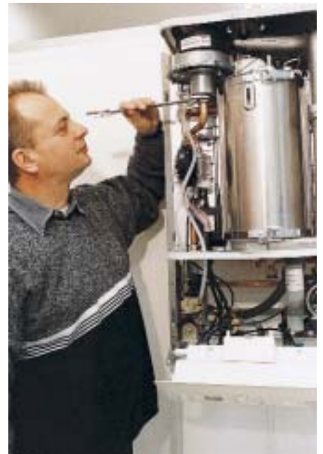
Die Überwurfmutter des Gasanschlusses wird gelöst, um bei der Umstellung von kleiner auf große Leistung die Abdeckung der Mischkammer zu entfernen
