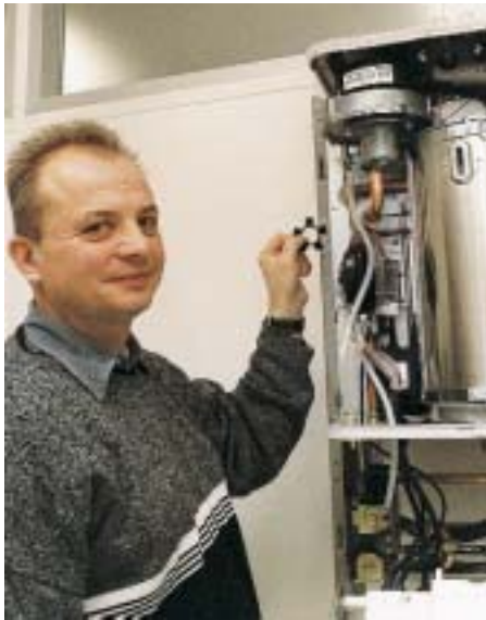
Bei der Umstellung von der kleinen zu großen Leistung wird diese Abdeckung nicht mehr gebraucht
