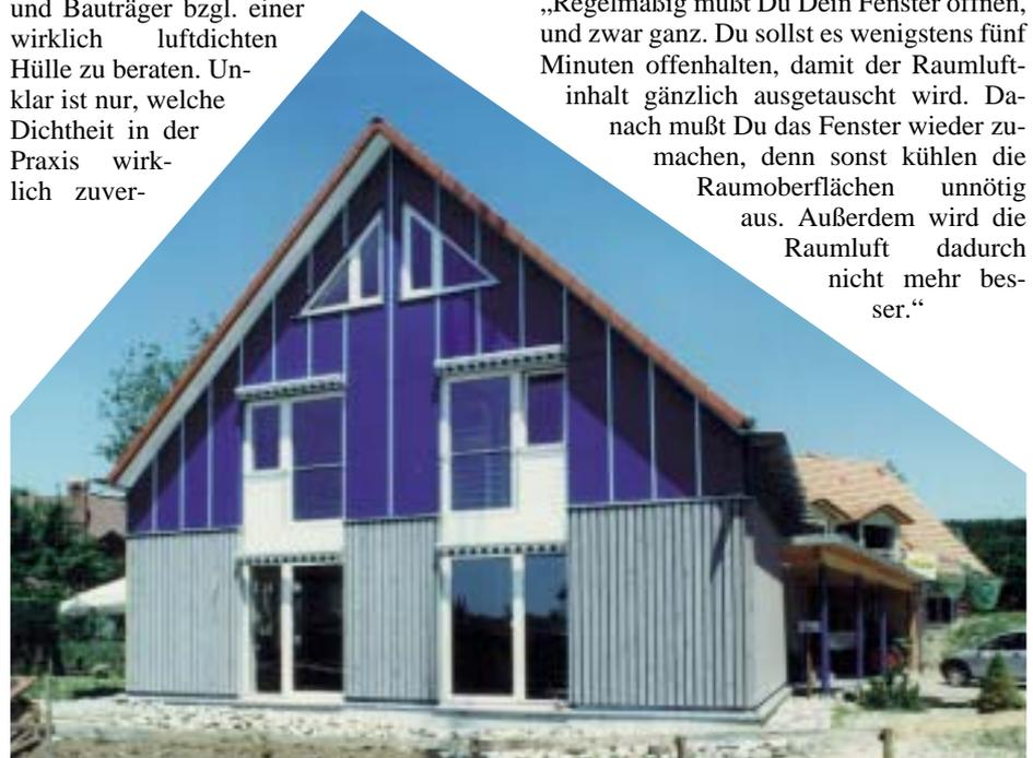
**Bild 2 Passivhaus in 88682 Salem: Lüftung: Fa. Paul (95 % Wärmerückgewinnung) sowie Erdwärmetauscher; Heizung: Elektro-Heizstab (6 kW), Verteilung über Wärmetauscher/Lüftungsanlage; ein Heizkörper im Bad; Vorrüstung für Pelletsofen**
