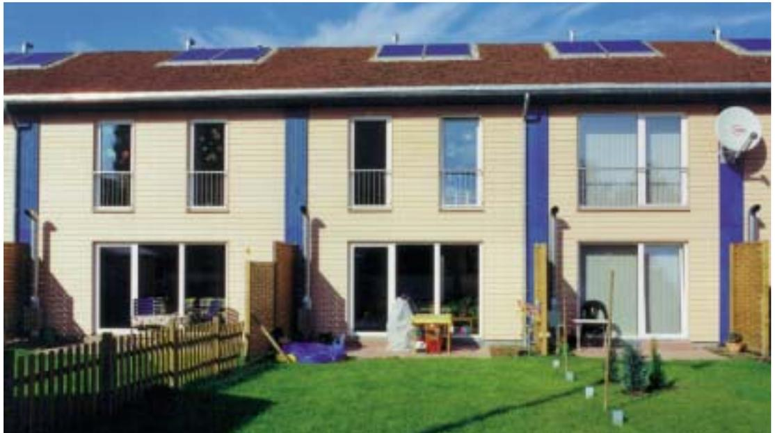
**Bild 4 Reihenpassivhaus-Zeilen mit sieben Wohneinheiten: Lüftung und WW-Bereitung je Haus: kontrollierte Lüftung (Kompaktgerät „Aerex“, Fa. Maico) mit Erdwärmetauscher und 4,7 m<sup>2</sup> Solarkollektoren**
