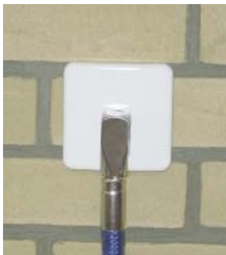
Vom Gasnetz im gesamten Haus läßt sich profitieren: Für die verschiedensten mobilen Geräte ist eine Gassteckdose stets in der Nähe
