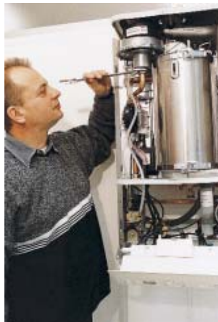
Die Überwurfmutter des Gasanschlusses wird gelöst, um bei der Umstellung von kleiner auf große Leistung die Abdeckung der Mischkammer zu entfernen
