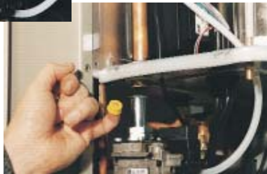
Die grüne Gasdrosselblende entspricht dem Leistungsbereich „öko“, die gelbe dem Leistungsbereich „plus“
