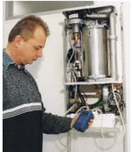
Nach Austausch des Drosseleinsatzes und der Gasdrosselblende müssen Gas-Luft-Verbund und CO 2 -Gehalt neu justiert werden
