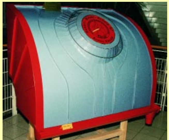
Beispiel einer Faltenkehle mit stark ausgeprägter Durchdringungslinie, Ausführung in farbbeschichtetem Aluminium (Meisterstück von Armin Kaupp)
