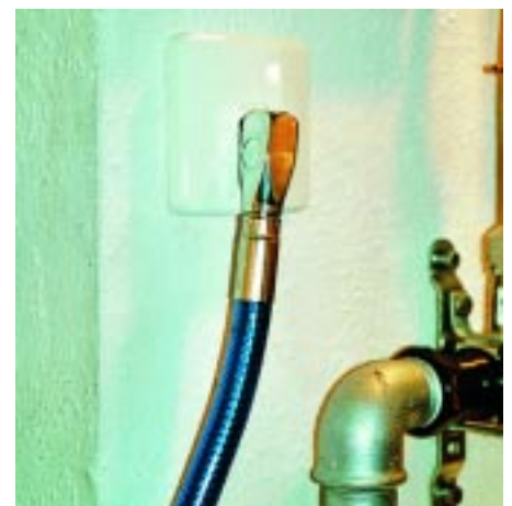
Bild 3 Vereinfachte Gas-Steckverbindungen, analog herkömmlichen Elektrosteckdosen hat die Firma Mertik-Maxitrol entwickelt
