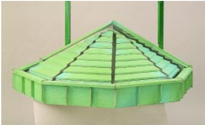
Ein Vordach, bekleidet mit vorbewittertem Kupferblech – Beispiel für die Kunstfertigkeit der in Stuttgart ausgebildeten Klempnermeister
