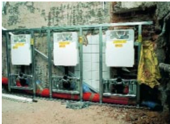
Die WC-Elemente des Varitec-Vorwandinstallationssystems sind mit Valsir-Spülkästen ausgerüstet [2]
