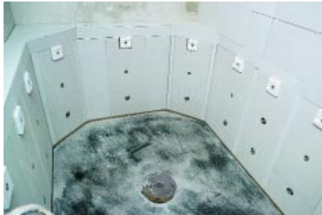
... und zeitsparend auch hier durch eine weitgehende Vorfertigung der erforderlichen VWI- und Beplankungsteile [2]
