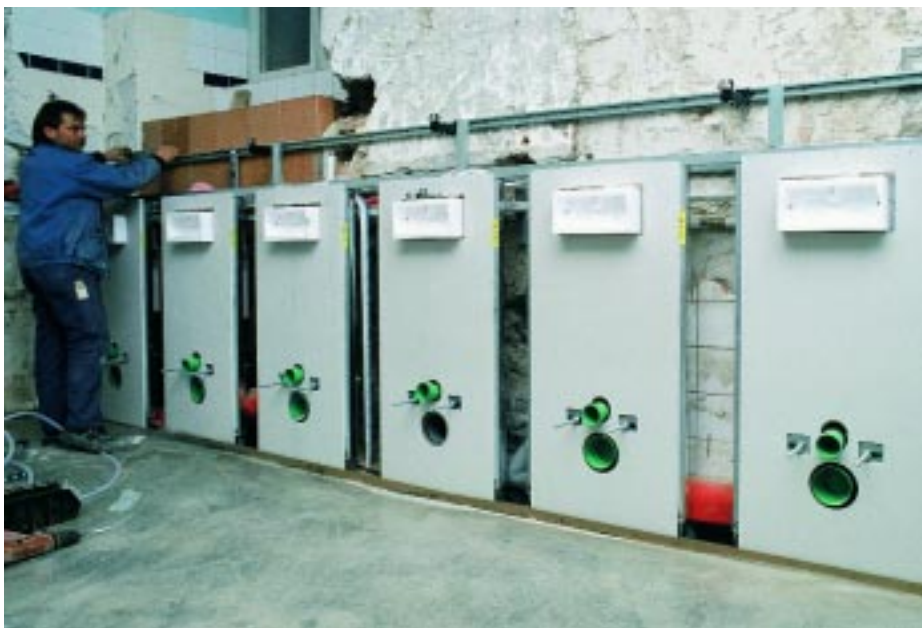
Werkseitig vorgestanzte wurden die Fermacellplatten für die Bepankung an der Baustelle angeliefert [2]
