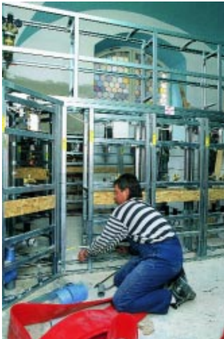
Für die neuen Urinalanlagen wurden Ecklösungen konzipiert – leicht umsetzbar mit dem VWI-System ... [2]
