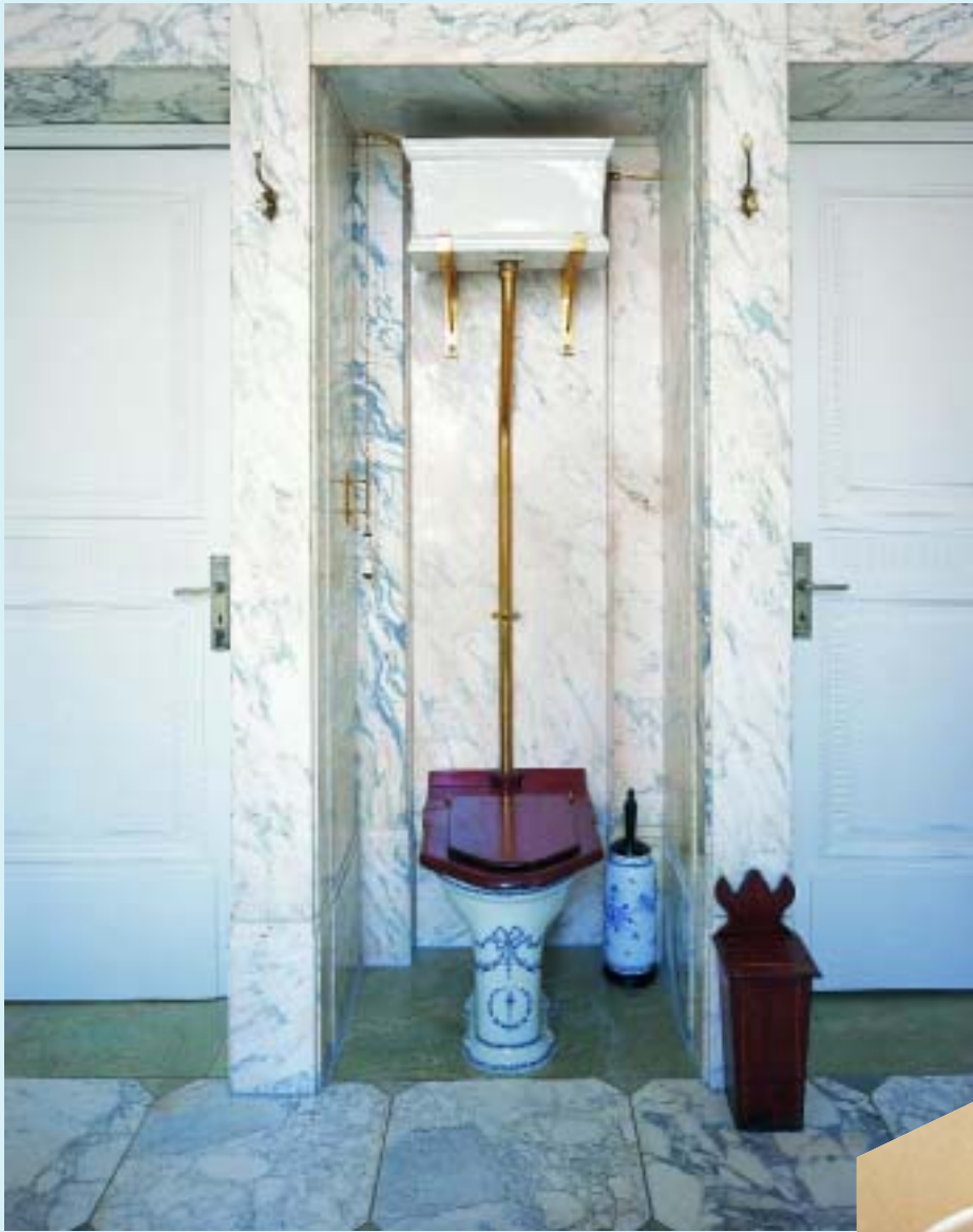
Voll funktionsfähig im Kundenhaus eingebaut: WC mit hochhängendem Spülkasten. Außen original 1880, im Spülkasten jedoch die modernste Technik
