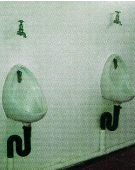
Diese Sparinstallation macht Handwaschbecken eigentlich überflüssig
